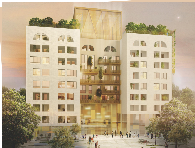
Deux exemples de projets liés au Grand Paris : la Tour H, restructuration de l'immeuble de l'ancien hôpital Louise-Michel, au cœur de la Zac Canal-Europe, à Courcouronnes (91)...
